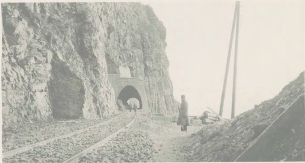
Тоннель на Кругобайкальской дорогѣ. № 7.
