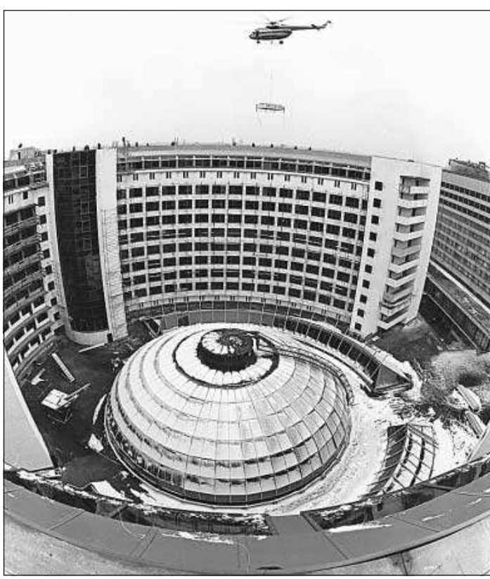
В минувшую субботу горожане вновь наблюдали за виртуозной работой вертолета авиакомпании «Спарк», пилотируемого знаменитым летчиком Вадимом Базыкиным. На крыше сооружаемого возле достройки «Санкт-Петербурга» бизнес-центра монтажники установили четыре вентиляционных агрегата, весящих каждый две тонны.
